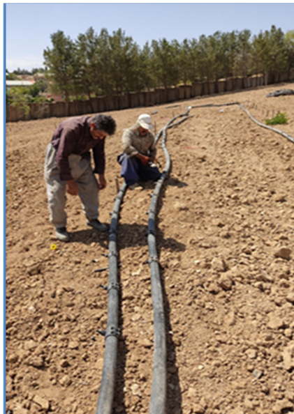
شکل ۱۵) افزودن کمرندهای انشعابی در فاصله ۶۰ سانتی‌متری (بر اساس فاصله ردیف‌های کاشت ۶۰ سانتی‌متری) در مزرعه (عکس از مازیار حیدری)
