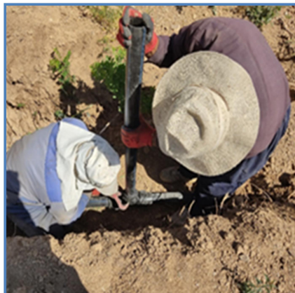
شکل ۱۴) لوله پلی‌اتیلن ۶۳ میلی‌متری برای استقرار سیستم آبیاری قطره‌ای و تیپ (نواری) در مزرعه (عکس از مازیار حیدری)
