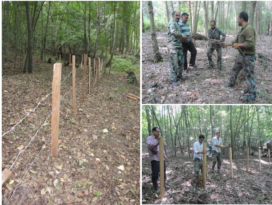
شکل ۴- عملیات حصارکشی با سیم‌های خاردار و پایه‌های چوبی، در اطراف تیمارهای جنگل کاری
