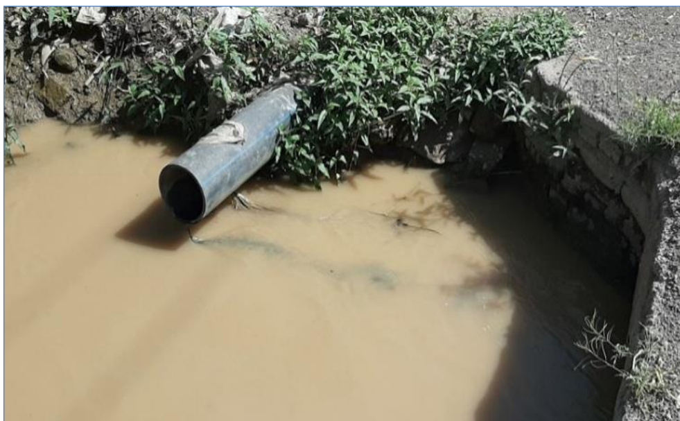
شکل ۴. ورود فاضلاب - کارگاهی به کانال آبیاری
